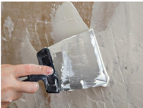
De muur voorbereiden
